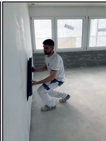
Grossflächiges Abziehen
